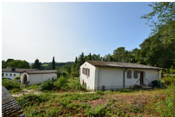
1.370 m 2 inkl. Abrisshaus
